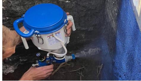
**BAUTER PRIMER** ist ein Produkt, das verwendet wird, um die Saugfähigkeit des Untergrunds zu verringern und die Trocknung von Dekorationsfarben zu verbessern. Durch die entsprechenden rheologischen Eigenschaften wird die Applikation verbessert und die Wandverluste des Erdreichs reduziert.
